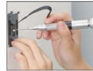
マウントベースの位置を調整してねじを締め付けます。
