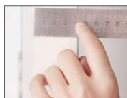
ドアの厚みを測って、適切なねじを選択します。
